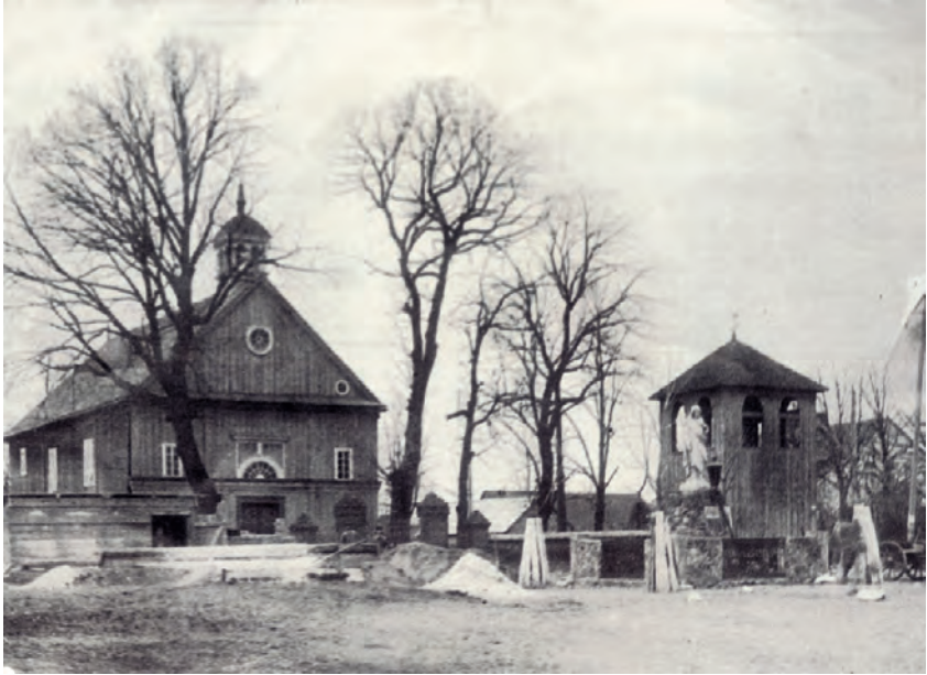
Kościół modrzewiowy pw. św. Floriana zbudowany w 1760 r. przez proboszcza brwinowskiego ks. Baltazara Antoniego Tarkowskiego, fot. ok. 1925 r.
